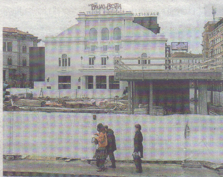
Colpo d'occhio Il cantiere che rovina la visuale sul Teatro Nazionale
